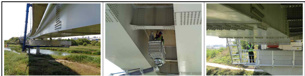
[고소작업차, 굴절점검차를 이용한 근접조사 실시]
